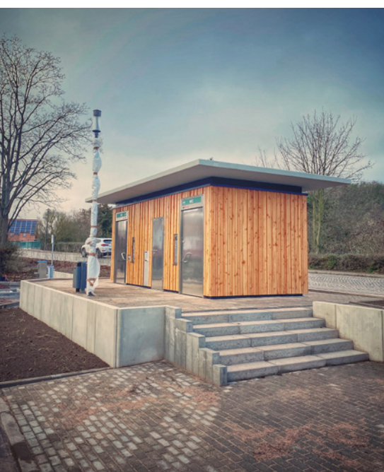
Toilettenanlage am neuen Wanderparkplatz © Stefan Seelig/Stadt Eisenach
