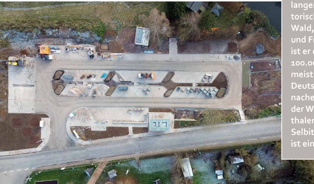
44 Stellplätze stehen auf dem Wanderparkplatz zur Verfügung. Das Bild zeigt die Bauarbeiten im November 2025. © Motasem Billah Saleh/Stadt Eisenach
