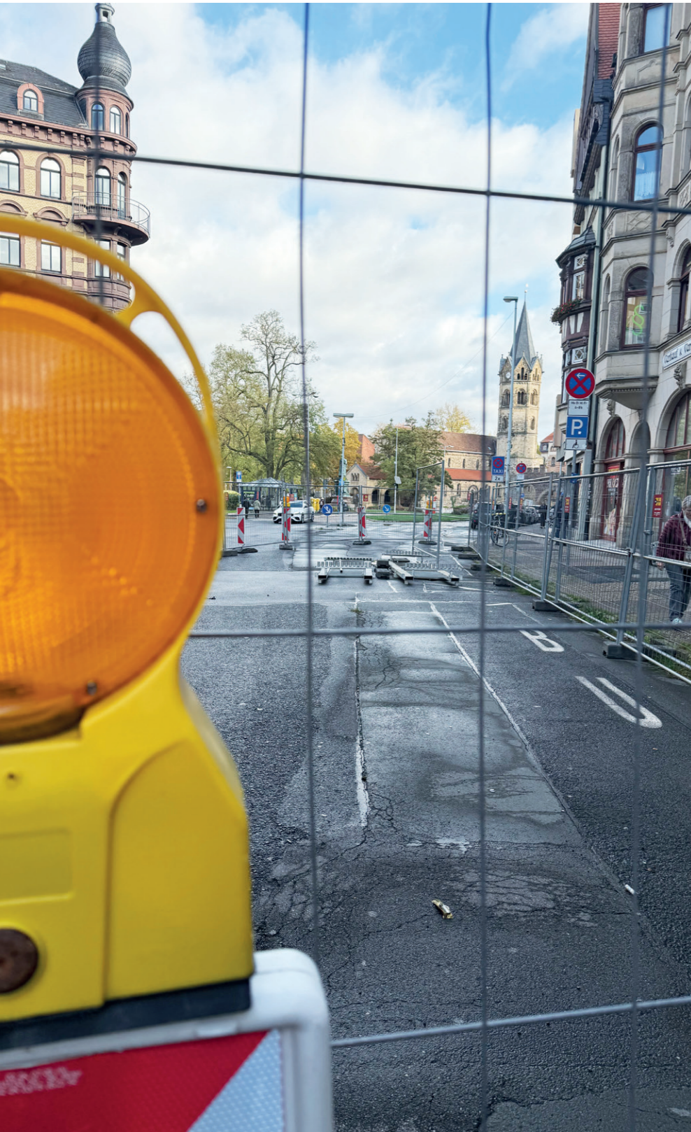
Über Tage sieht die Baustelle unscheinbar aus. Es wirkt, als gingen die Arbeiten nicht voran.
